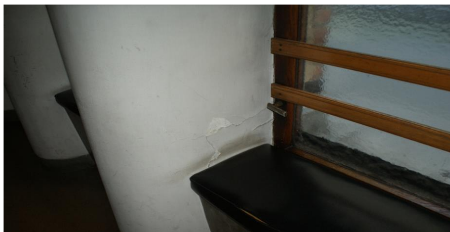
Zdjęcie zablokowanych przez „siedziska” okien – montaż „siedzisk” wyklucza otwarcie okien i wietrzenie pomieszczenia
