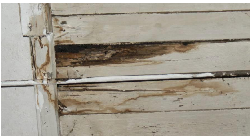
Zdegradowane elementy stropu w magazynie
